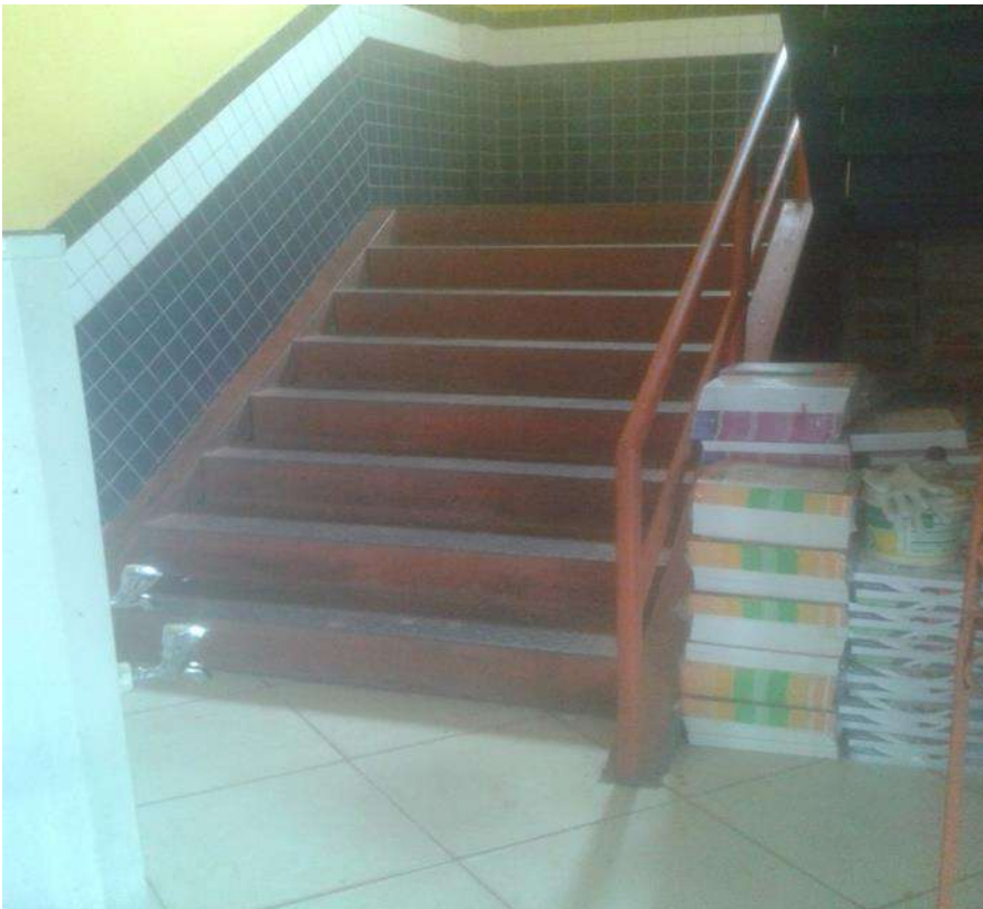
Fig. 2.1 escada de dois lances. Fonte: Autor (2017).
