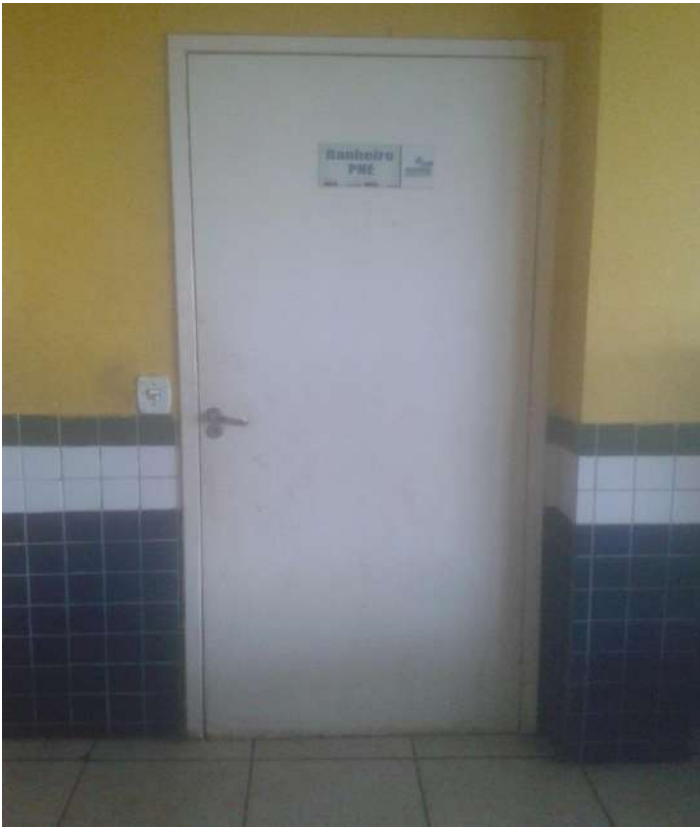
Fig. 3 banheiro PNE. Fonte: Autor (2017).
