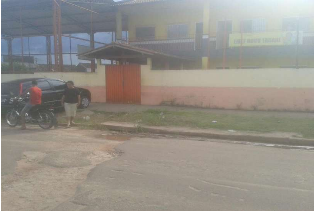
Fig. 1 frente da escola Novo Tauarí. Fonte: Autor (2017).
